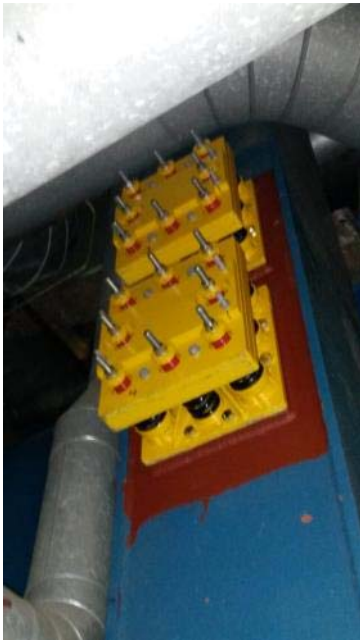
Schwingungstilger an Fundamenten
